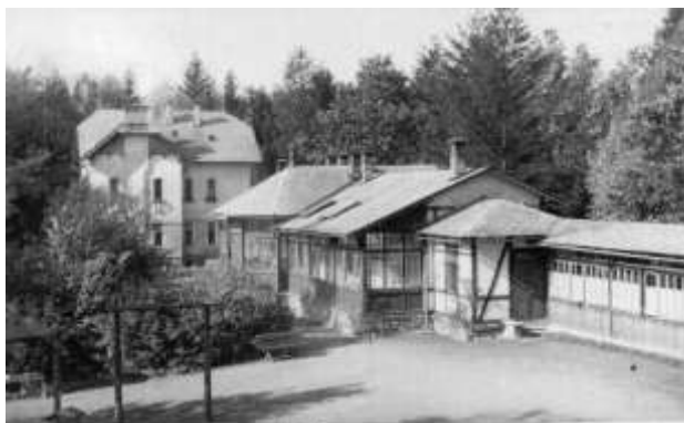
Obrázek 3: Letní pavilon s jídelnou a vodoléčbou, rok 1930
