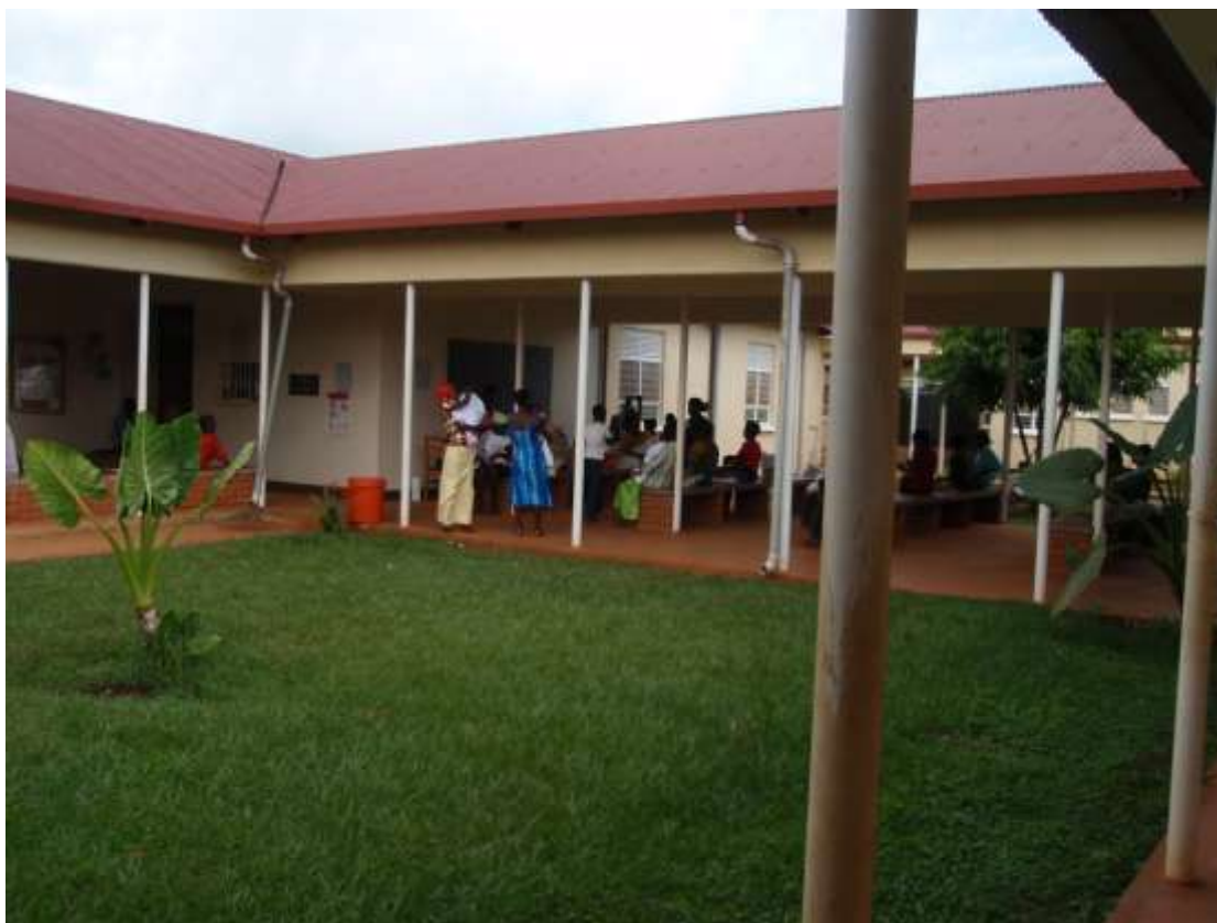
Obrázek č. 11 Čekárna v Buikwe (18)
