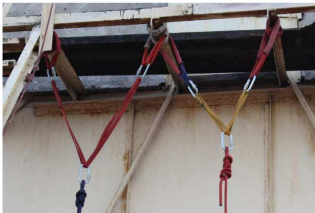
Obr. 21 – Ochrana textilních kotevních prvků proti poškození opletu a útků, užití hadicí typu „D“ na nosných profilech lávky. (Autor)
