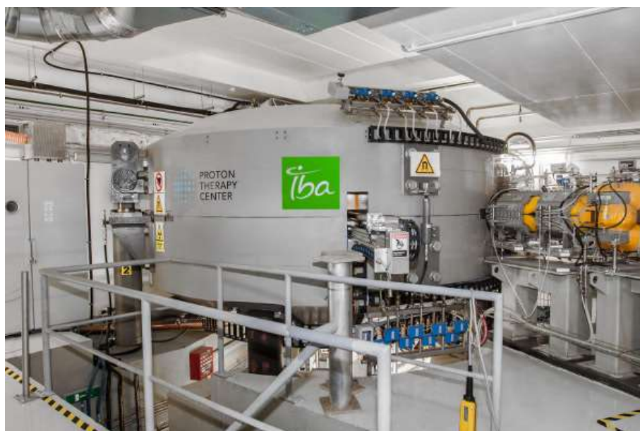
Obrázek 3 Cyklotron Proteus 235
