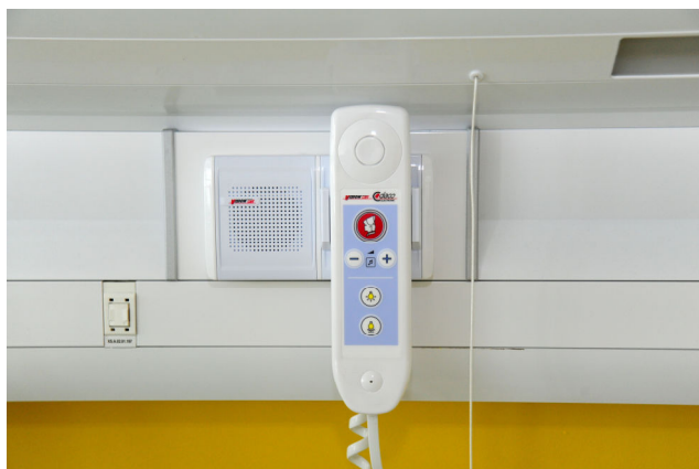
Obr. 5.1-9: Sluchátko s mikrofonom - jedna část oboustranného signalizačního zařízení
